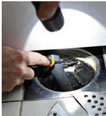
Sluket er noe av det første som sjekkes på inspeksjon.
