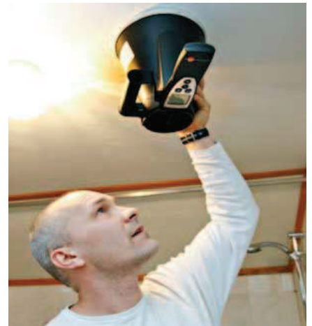
Roger Zachariassen sjekker ventilasjonen på badet.
